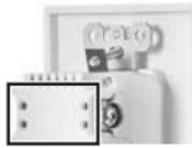
**6** Apriete todos los tornillos y asegúrese de que no alambre de cobre desnudo esté expuesto. Al apretar los tornillos, utilice 14 libras de torque por pulgada.
